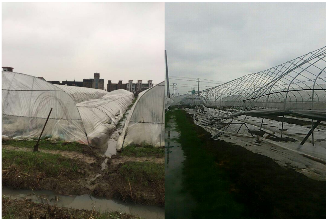
孙端镇（左）和富盛镇（右）农业设施受损情况
